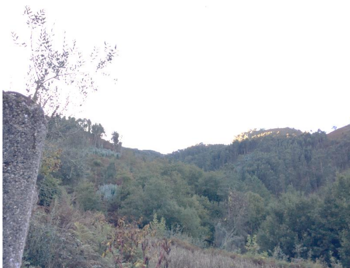
Fotografia 5.18 – Panorâmica do vão dos apoios P3 e P4
