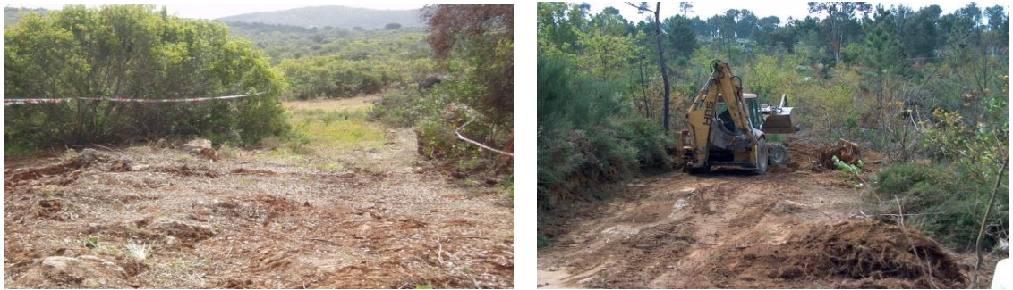
Fotografia 4.1 – Pormenor dos acessos existentes e a construir
