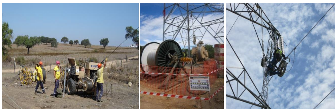
Fotografia 4.4 - Colocação dos cabos
