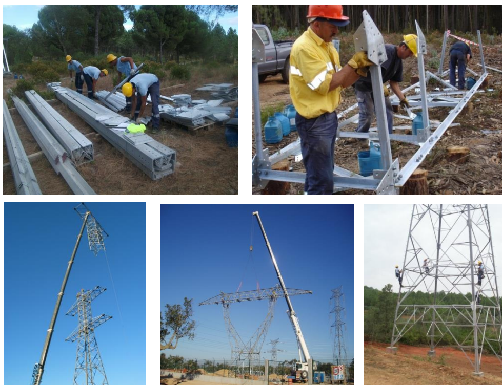
Fotografia 4.3 - Montagem e levantamento dos apoios
