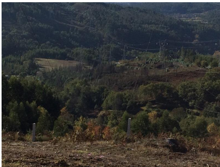
Fotografia 5.22 – Panorâmica do vão dos apoios P8 e P9
