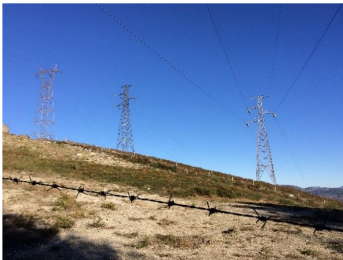
Fotografia 5.20 – Local de implantação do apoio P7
