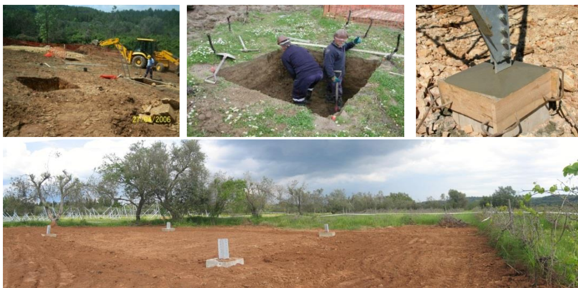
Fotografia 4.2 - Execução das fundações dos apoios da linha
