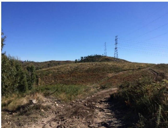
Fotografia 5.35 – Local de implantação dos apoios P57 e P58
