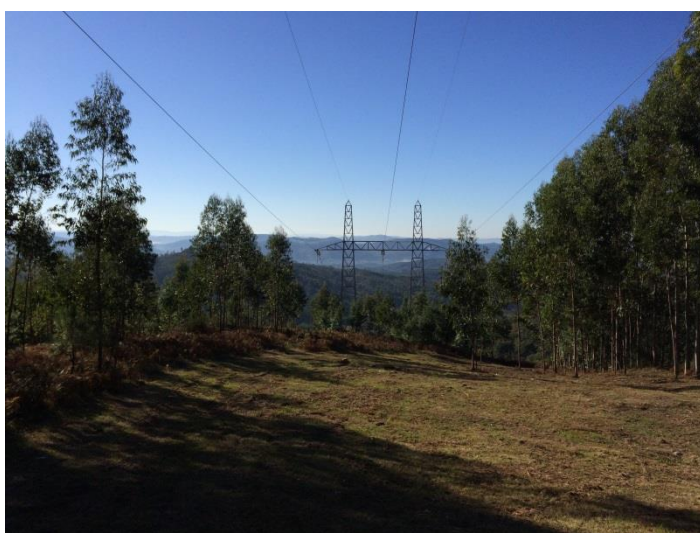
Fotografia 5.21 – Local de implantação do apoio P8
