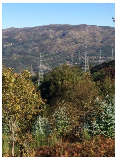
Fotografia 5.19 – Panorâmica do vão dos apoios P5 e P6
